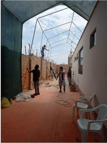
Aufbau des Zeltdaches in der Gesundheitsstation durch Umfunktionung beschädigter Zelte
