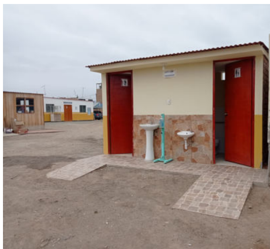
Die neuen Toiletten im Hof der Gesundheitsstation
